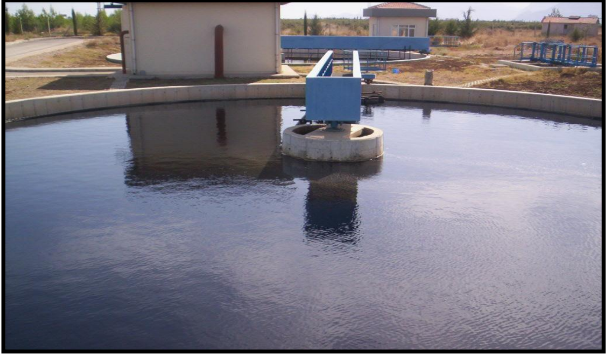
Son Çökeltme Havuzundan Görünüm
